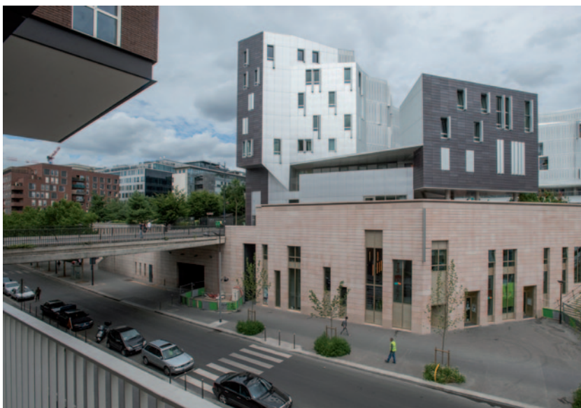
Immeuble Chevaleret Grands Moulins, 13 e .
