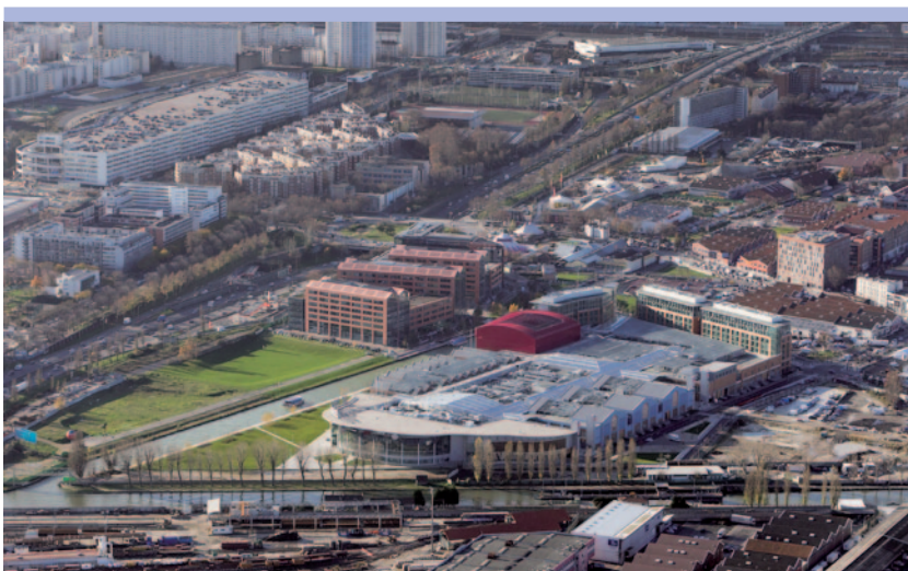
En 2012, 300 logements de toutes catégories, une école polyvalente de 12 classes, une halte garderie de 30 berceaux, un EHPAD de 104 chambres et 41 000 m 2 de bureaux ont été inaugurés sur le secteur de la ZAC Claude Bernard.
