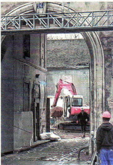
La ferme Montsouris (XIV e ), lundi. Les ouvriers de la Soférim ont entamé les travaux de démolition. (DR.)
