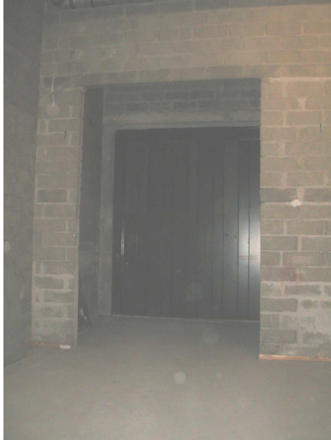
Le vaste monte-charge relié au sous-sol du parking Italie 2
