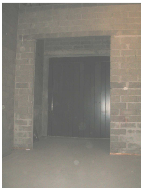
Entrée du monte-charge relié au sous-sol du parking Italie 2
